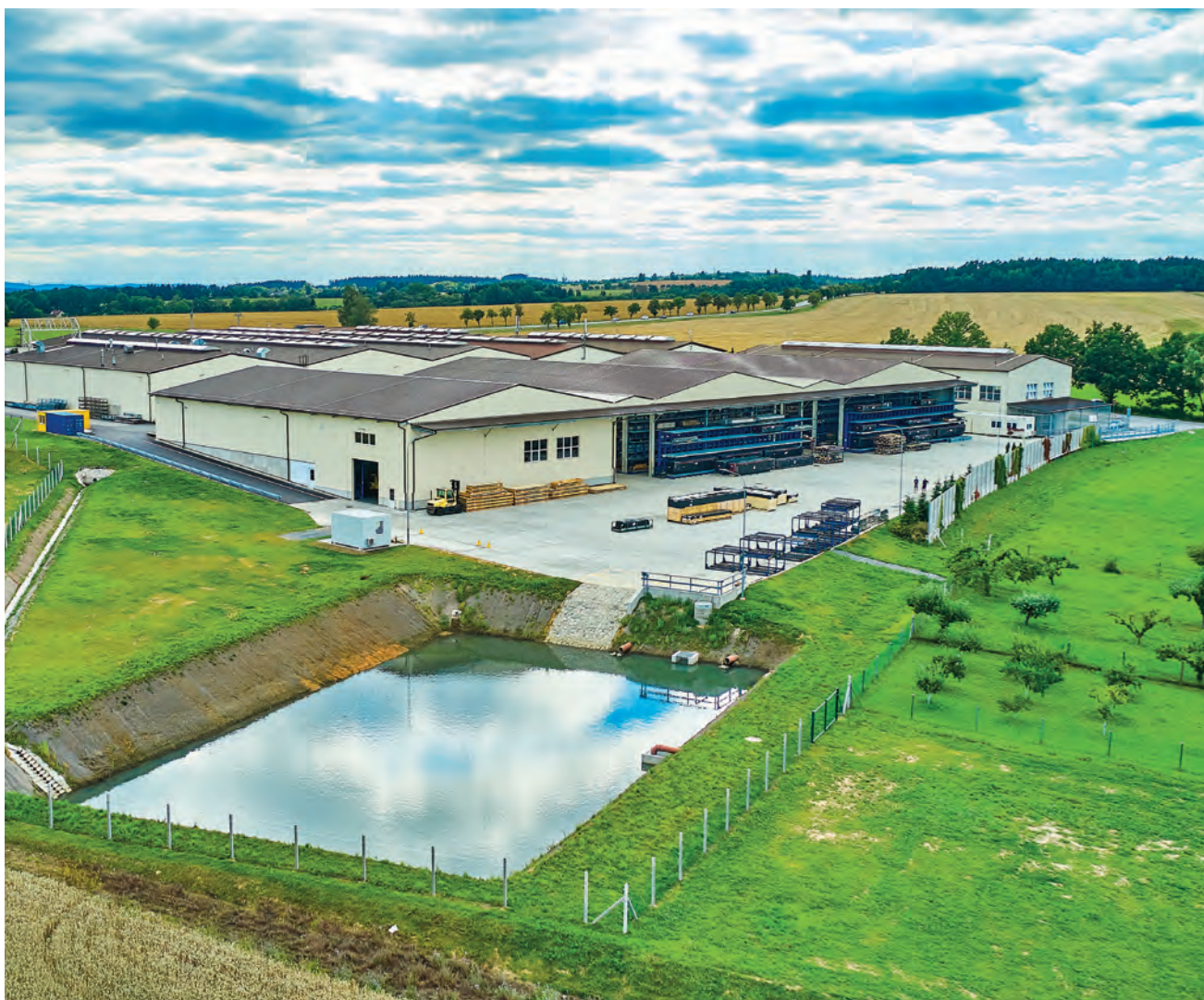
Nová skladová hala a retenční nádrž EFAFLEX, Olší
